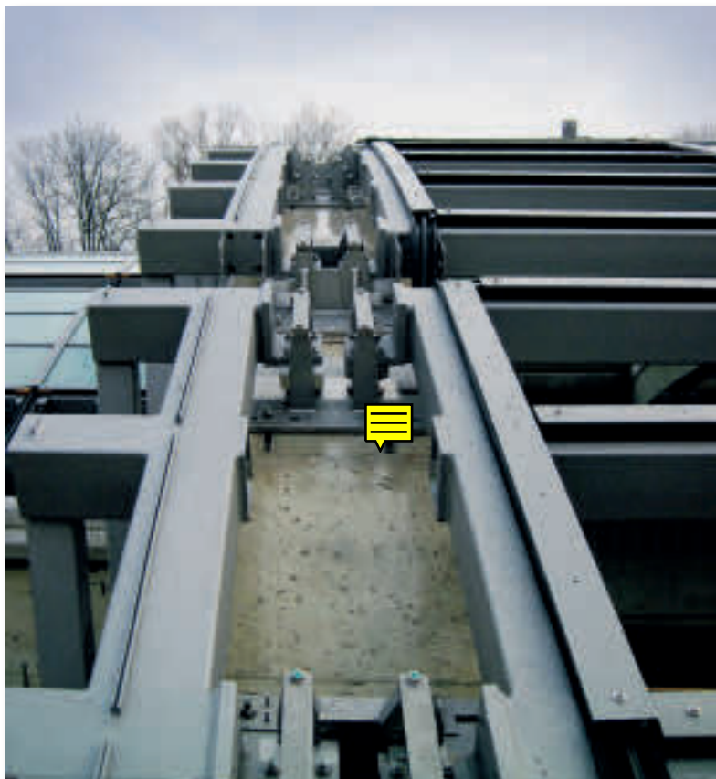
W szklanej konstrukcji dachu ekranu akustycznego autostrady w Kolonii-Lövenich zastosowano do mocowania agregatów wentylacyjnych szyny Halfena z wysokoodpornej na korozję stali nierdzewnej. (Zdjęcie: © Levia)
